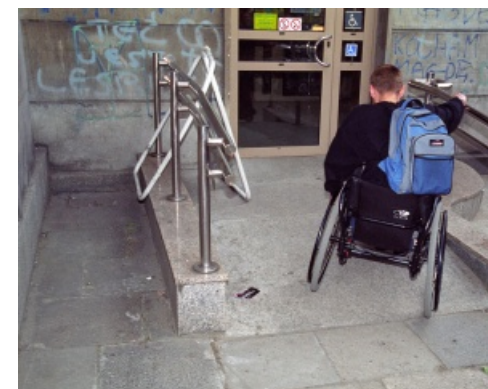
Fotografia 4.2. Zbyt stroma pochylnia z ograniczonym przez reklamę dostępem do poręczy utrudnia osobie poruszającej się na wózku podjechanie.
