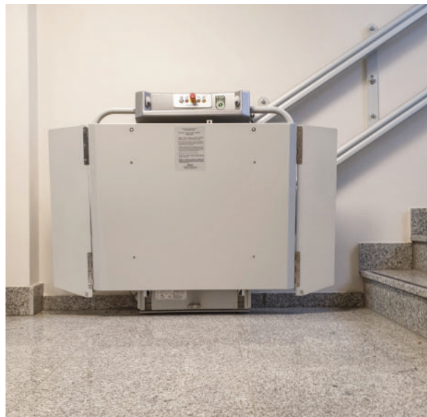
Fot. 10 Podnośnik schodowy poruszający się przy ścianie na specjalnej szynie, archiwum Global Lift Polska
