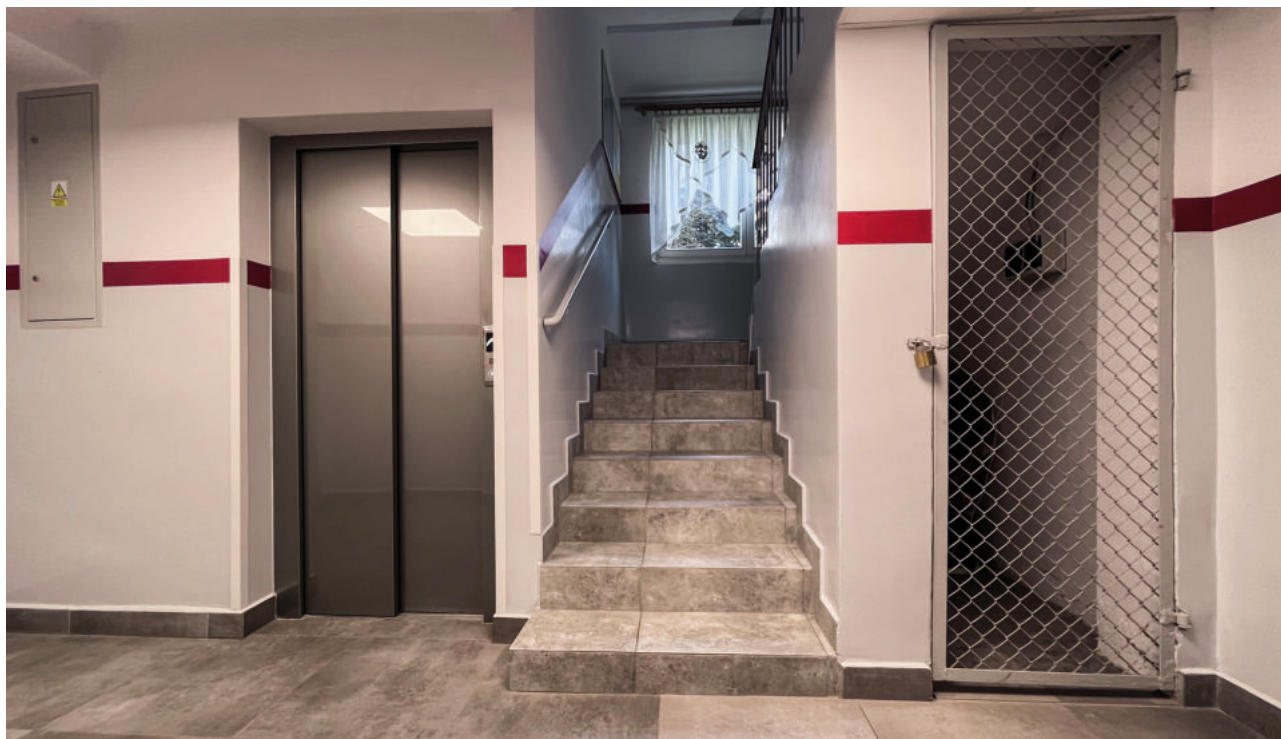
Fot. 4 Dodatkowy poziom zatrzymywania się windy wykonany dzięki wykorzystaniu pomieszczenia na kontenery na śmieci pod dawnym zsympem, fot. Archiwum Jeleniogórskiej Spółdzielni Mieszkaniowej
