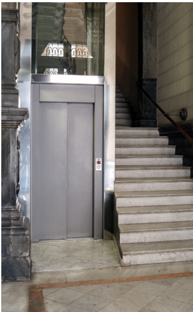
Fot. 1 Winda zbudowana w duszy klatki schodowej, archiwum Global Lift Polska
