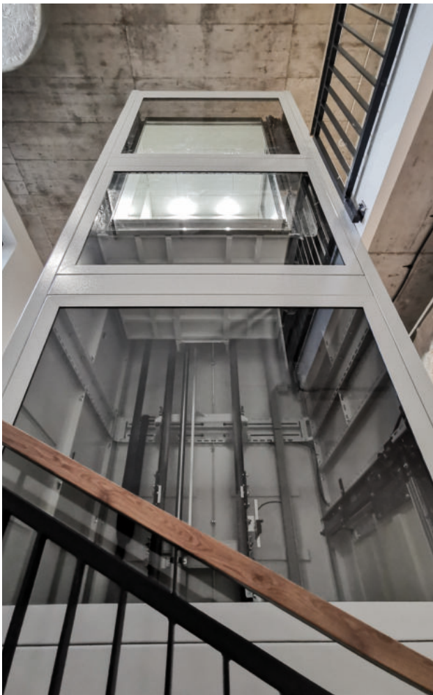
Fot. 2 Platforma z szybem samonośnym w duszy klatki schodowej, archiwum Global Lift Polska
