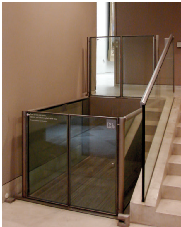
Fot.8 Podnośnik pionowy wewnętrzny, umożliwiający pokonanie schodów w środku budynku. Archiwum Fundacji Integracja
