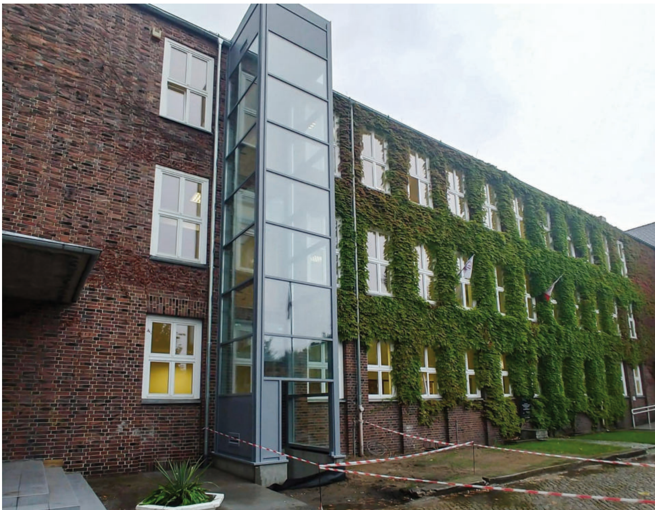
Fot. 5 Winda dobudowana na zewnątrz budynku. archiwum Global Lift Polska
